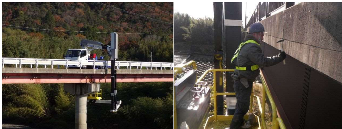
写真 2 近接目視の点検状況（橋梁点検車）
