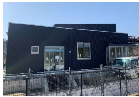
▲ボルダリング施設（建設中）
