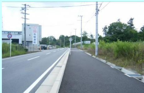
歩道が拡幅され、歩きやすくなった小口八重谷線
