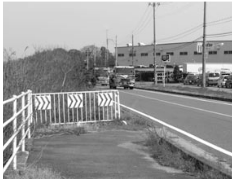
国道477号線・行き止まりの歩道
