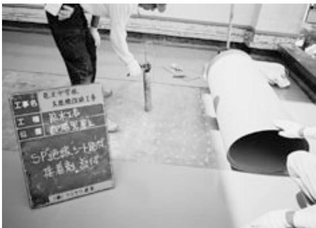
竜王中学校配膳室屋上工事の様子
