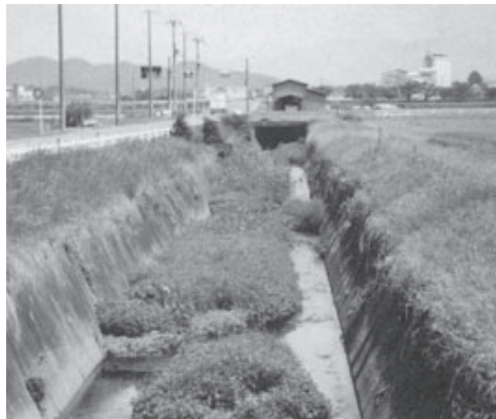
浚渫工事を一日も早く！！ 寒尻川
