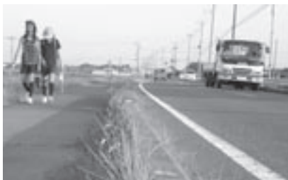
車道と歩道の縁石が低くなっている県道
