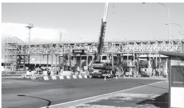
竜王インター改良工事
