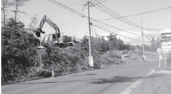
町道小口八重谷線歩道工事
