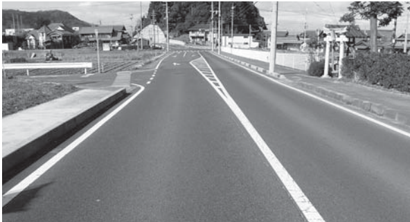
路面表示設置工事
