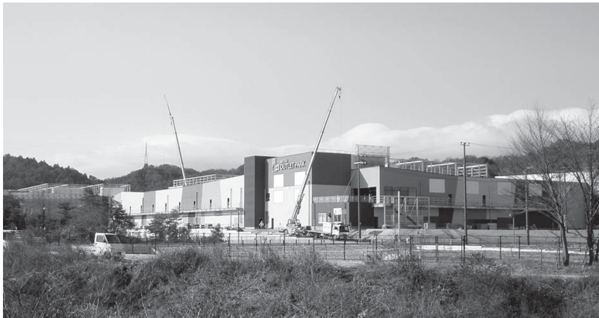
着々と進むアウトレットモール建設
