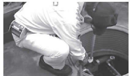
浄化槽の点検作業
