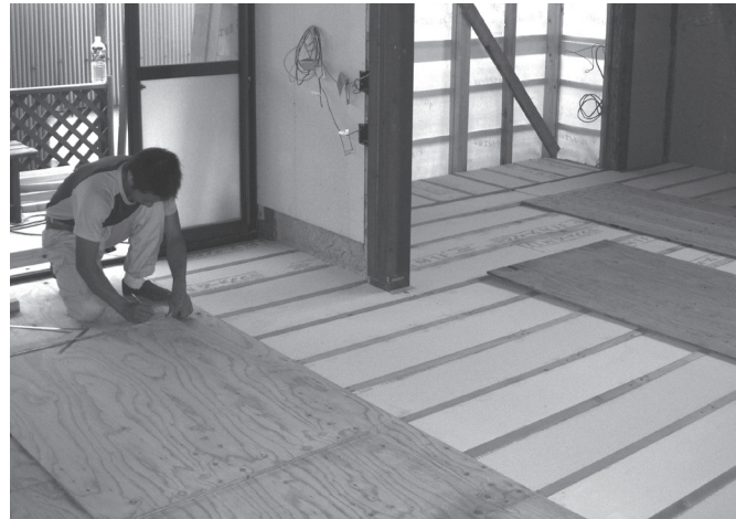
住宅リフォーム「和室が洋室に生まれかわります」
