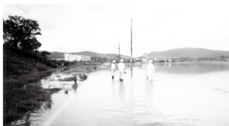
中津井川（弓削）増水による浸水状況
