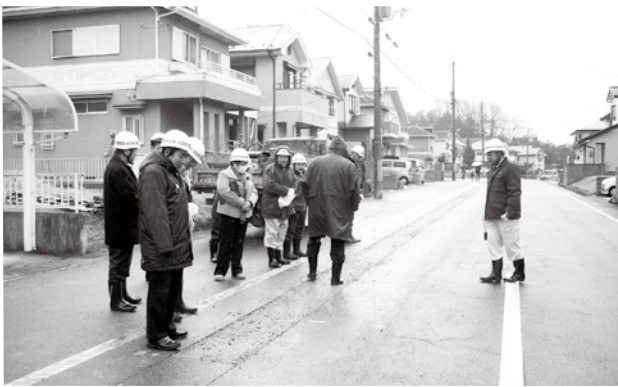
松が丘、石綿管の布設替工事現場
