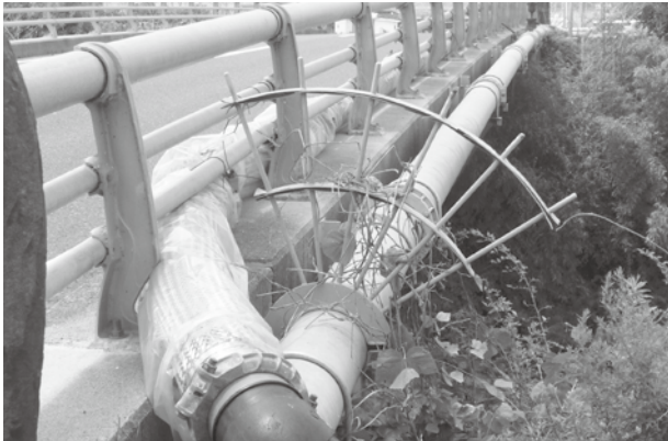
巡検橋仮設配管の状況
