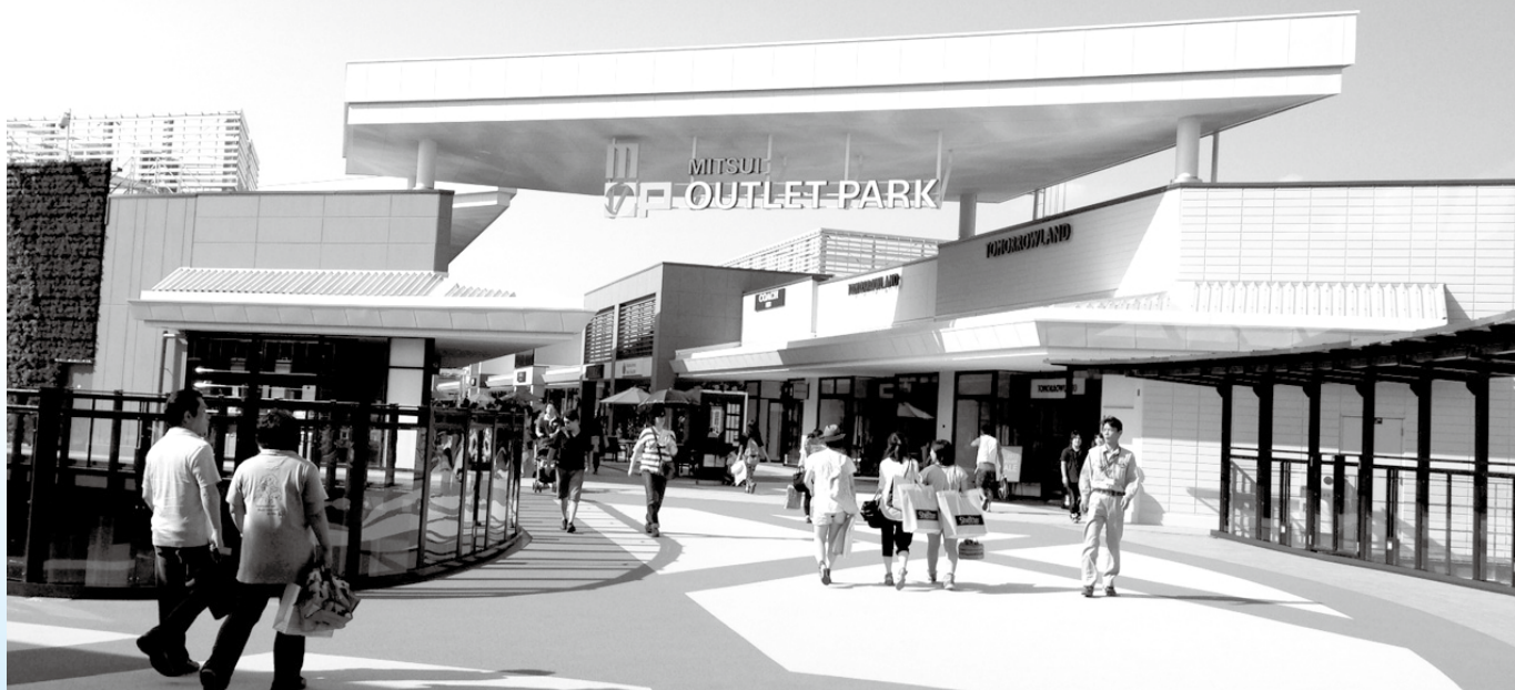
上：新設されたワークマン竜王流通センター 下：増床した三井アウトレットパーク
