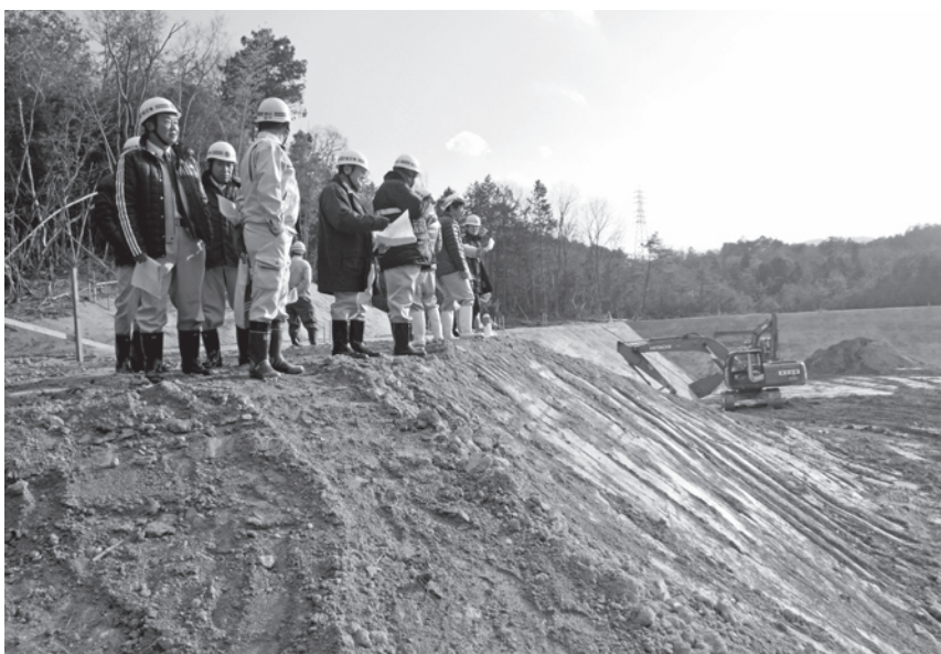
滋賀竜王工業団地の現場視察
