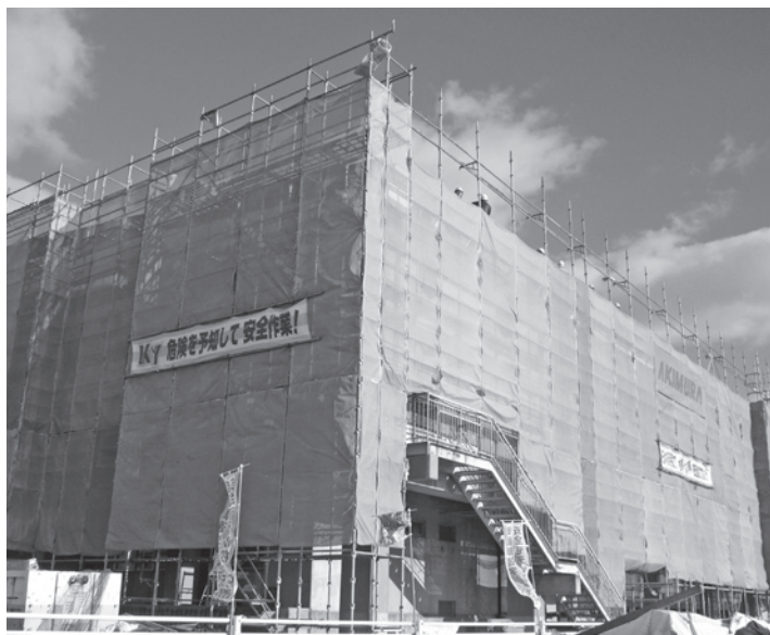
改修工事中の中学校体育館
