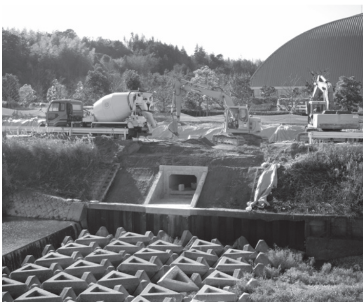
多機能グラウンド整備(放流管)工事
