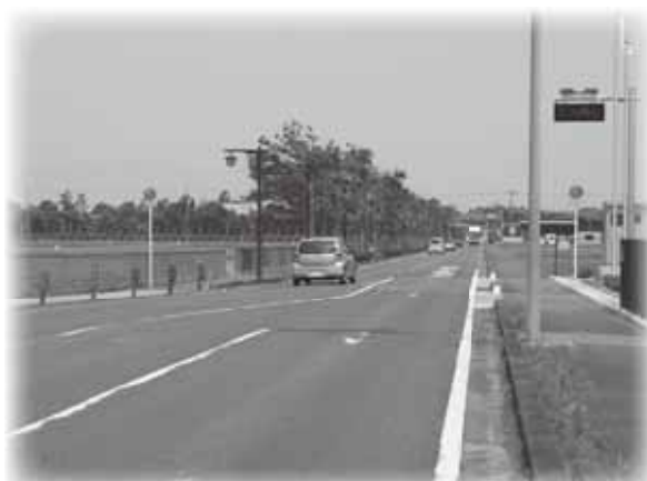
▲道路改良・舗装工事が計画されている個所（町道中央通り線）
