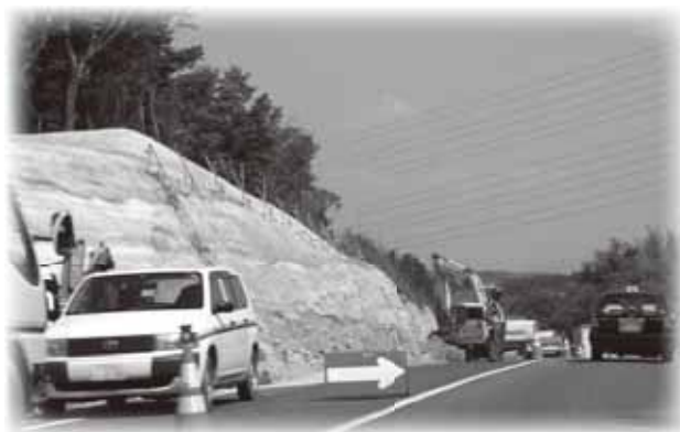
▲歩道の拡幅工事が予定されている個所（国道477号）
