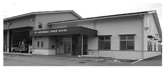
竜王消防出張所の土地造成 総務費 3,251 万円 防災拠点施設（水防備蓄倉庫など）の整備 消防費 4,921 万円
