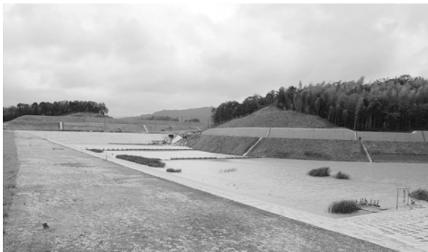
フェンス工事が予定されている1号調整池
