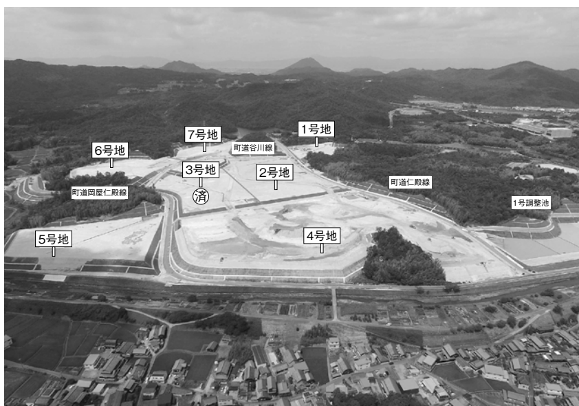
完成が近づく滋賀竜王工業団地(7月末の進捗状況)
