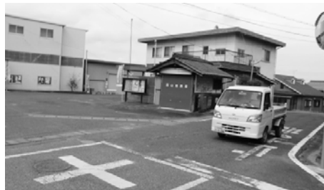
耐震工事を待つ集落の公民館
