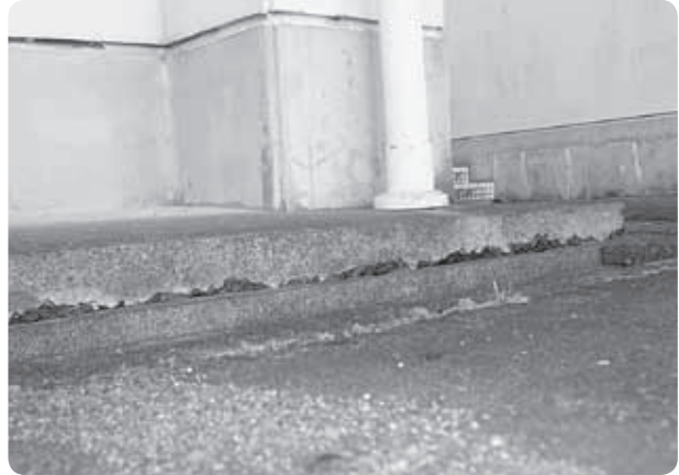
校舎コンクリート部の地盤沈下
