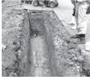
用水管の漏水状況
