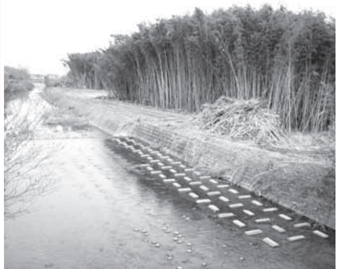
竜王大橋（小口）下流の竹木伐採工事の様子
