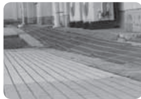
側溝の傾きによるグレーチングの変形
