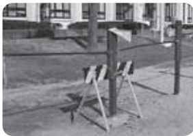
グラウンドの鉄棒の沈下
