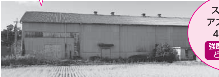
昭和47年建設された竜王町南部地区防災センター（岡屋）
