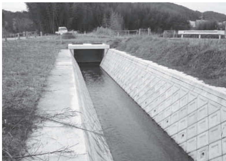
広谷川の薬師・不動尊線の函渠工の施工現場
