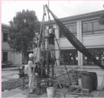
地質調査ボーリングの様子
