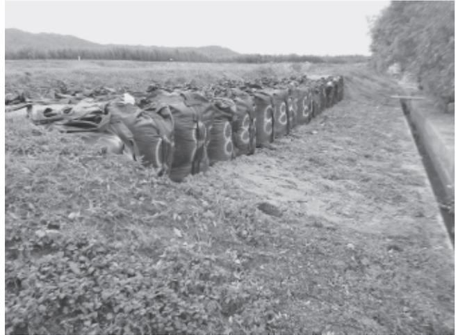
災害復旧予定地（新川の決壊箇所・大型土のうで応急復旧）
