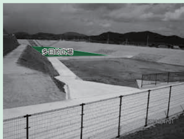
調整池に設置されたフェンス
