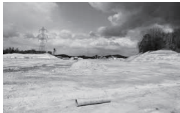
造成工事が進む小口工業地域
