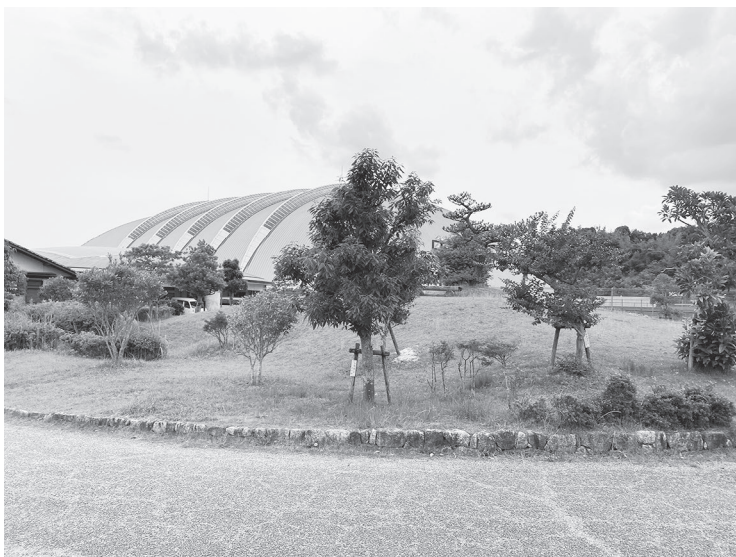
ボルダリング施設の建設予定地（写真中央）
