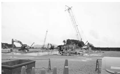
滋賀竜王工業団地進出企業工事中
