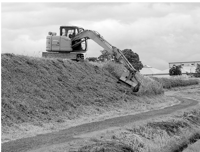
機械による河川愛護の様子
