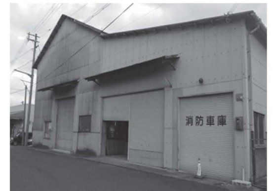
取り壊し予定の南部地区防災センター
