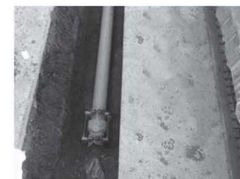
下水道管の布設の様子
