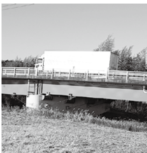
修繕した竜王大橋（小口地先）
