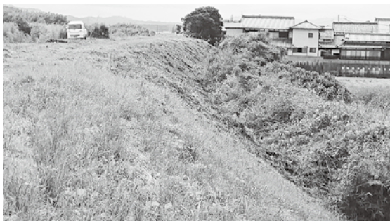
日野川堤防 左岸法面
