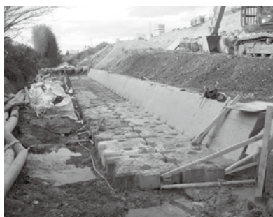
改修中の基礎部分
