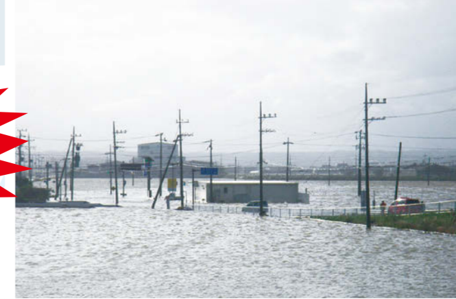
平成29年台風第21号による被害・弓削交差点周辺
