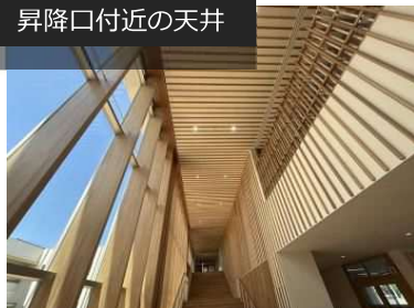
昇降口付近の天井
