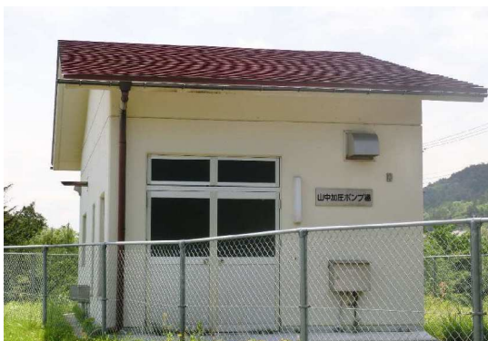
山中加圧ポンプ場
