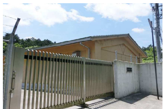
小口加圧ポンプ場
