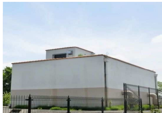
山之上配水池
