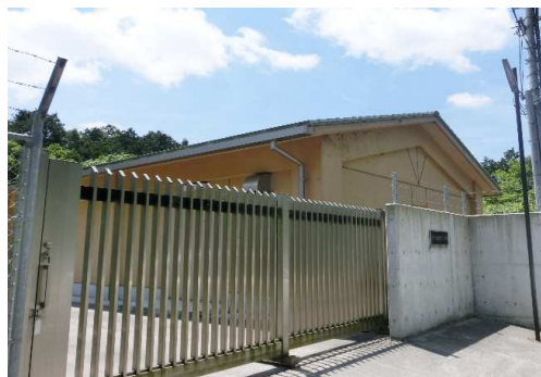
【 小口加圧ポンプ場 】
