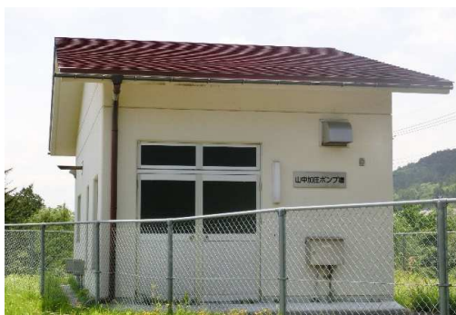
【 山中加圧ポンプ場 】
