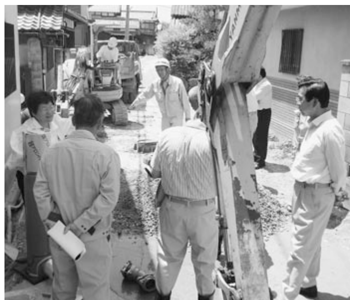
岡屋の下水道工事現場を視察しました
