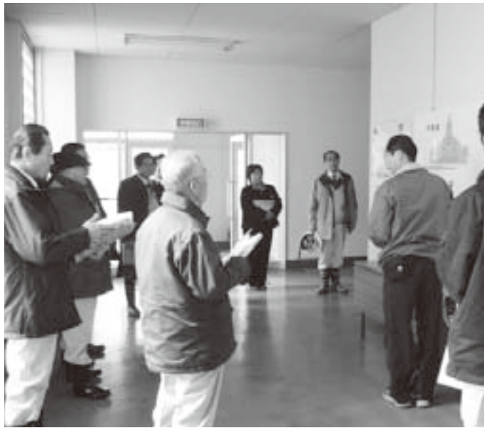
日野川農業水利第1段揚水機場
