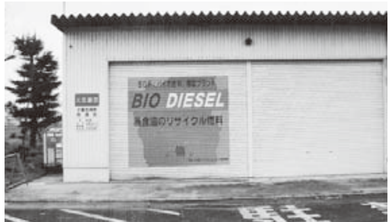
廃食油のリサイクル燃料製作所
