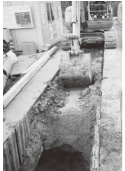
公共下水道工事（薬師地先）
