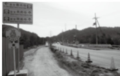
国道477号拡幅工事
