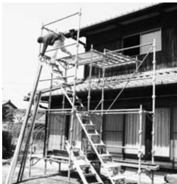
住宅リフォーム中のN宅
