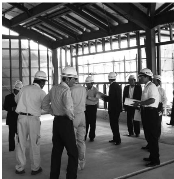
スポーツジム、スタジオが予定されている施設にて(岡屋・運動公園内)
