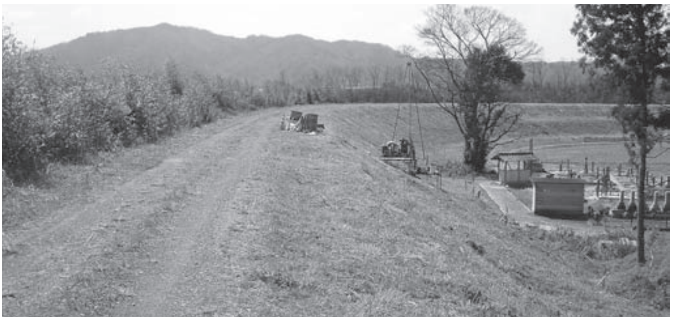
日野川堰堤のボーリング調査
