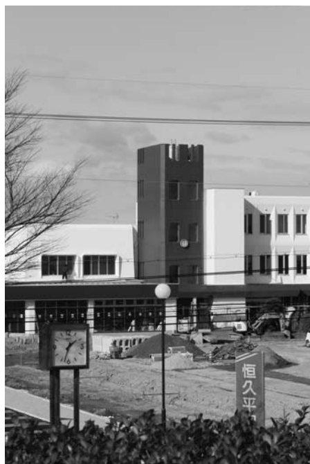
改修がすすむ公民館
