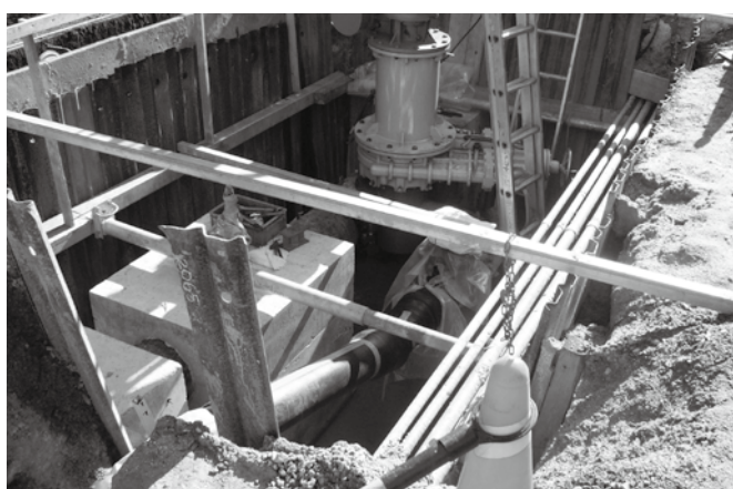
山中配水池耐震化工事
