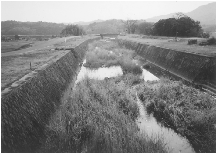
祖父川川床の現状
