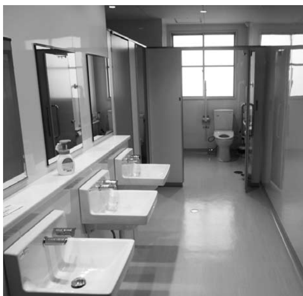
竜王小学校 改修後のトイレ
