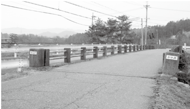
祖父川にかかる小口橋
