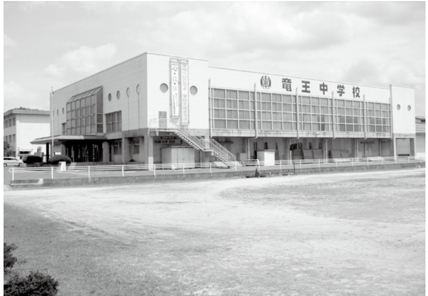
竜王中学校体育館（本年度屋根改修予定）
