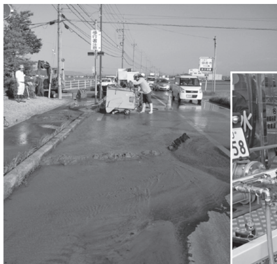
弓削地先配水管漏水と給水の様子
