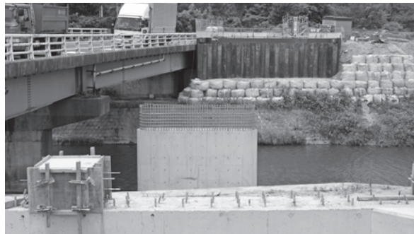
岡屋交差点改良工事
