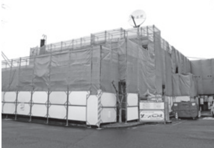
改修工事中の庁舎別館
