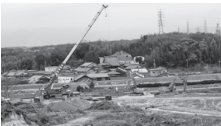
造成が進む滋賀竜王工業団地
