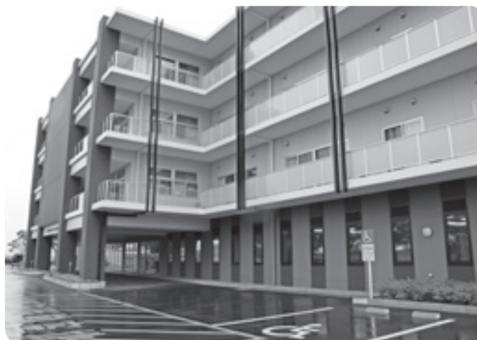
介護老人保健施設 エスペラル近江八幡 (小船木町)
