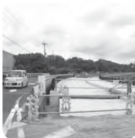
岡屋交差点改良工事
