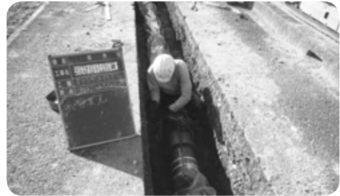
水道管布設替工事
