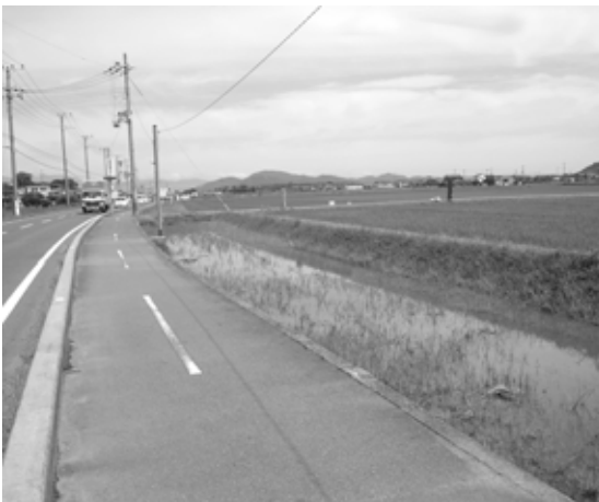
歩道拡幅工事中の橋本付近
