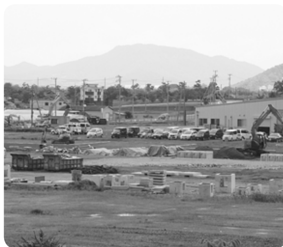
開発工事に着手
