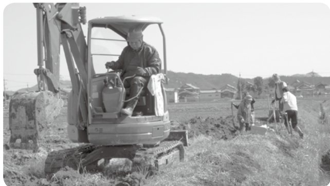
農家による修繕作業
