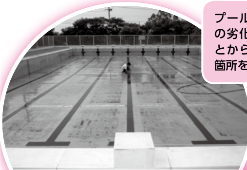
竜王西小学校 プール改修工事 1,485万円
