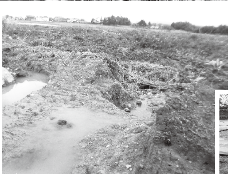
新川(弓削地先)の決壊箇所
