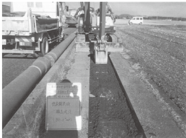
基幹管路布設替工事（橋本地先）
