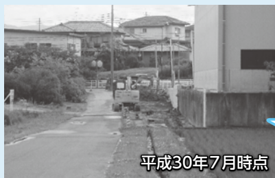
用地取得部分の擁壁が撤去された
