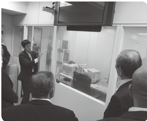
防災行政無線放送室
