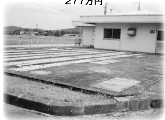
殿村地区農村下水処理場
