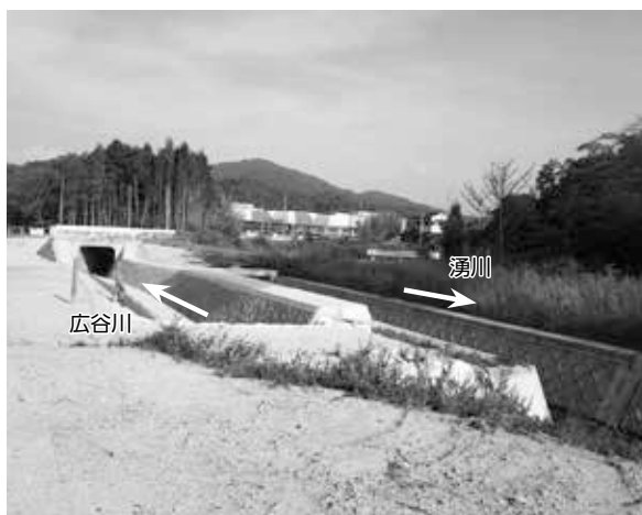
改修を待つ広谷川
