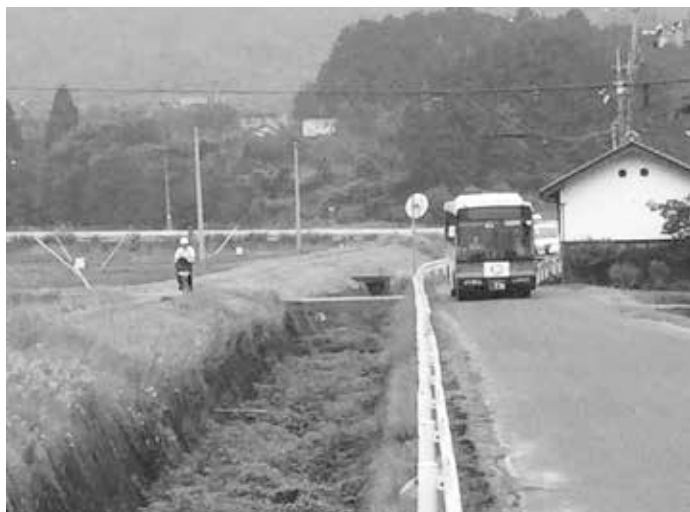
町道山中谷田線の現状
