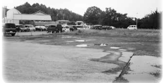
駐車場の造設予定地
