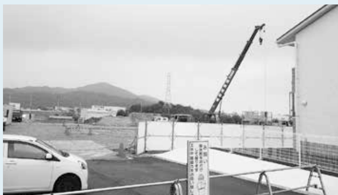
建設が進む2棟のアパート (小口地先)
