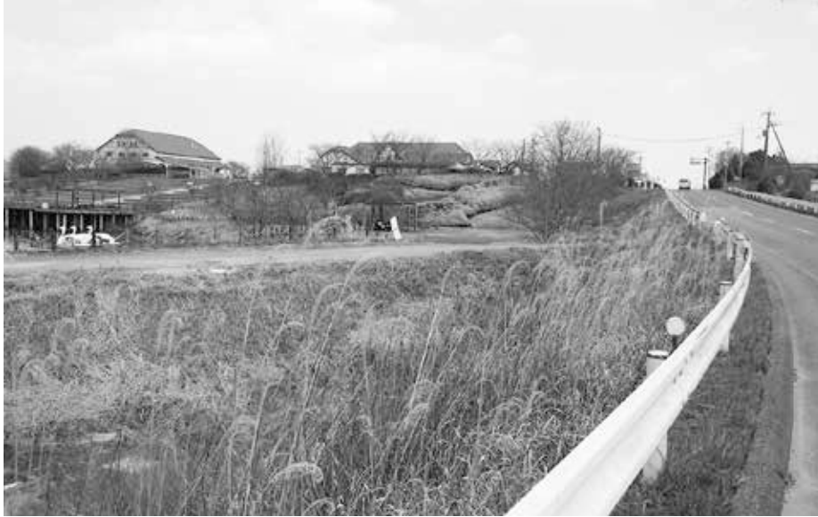
歩道整備が待たれる国道477号
