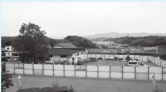
工事に着手した直売所
