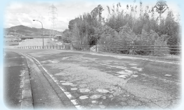
町道竜王近江八幡八日市線（雪野山大橋付近）
