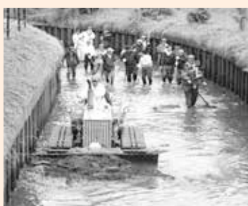
重機を使用した作業風景
