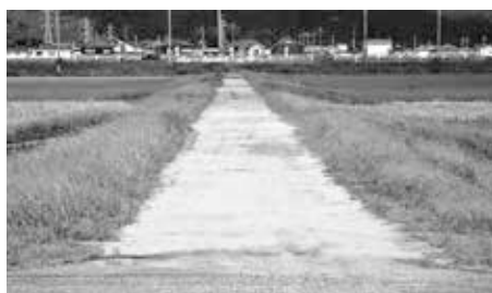
(上) ひび割れた用水路 (下) 農道（砂利道）
