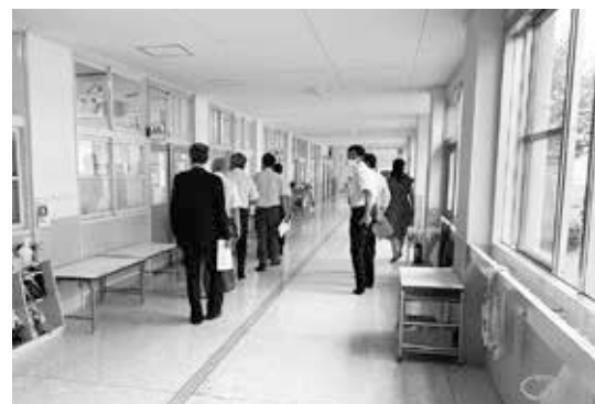
小学校の建物の状況視察
