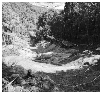
平成25年台風18号による土石流現場(鏡山)
