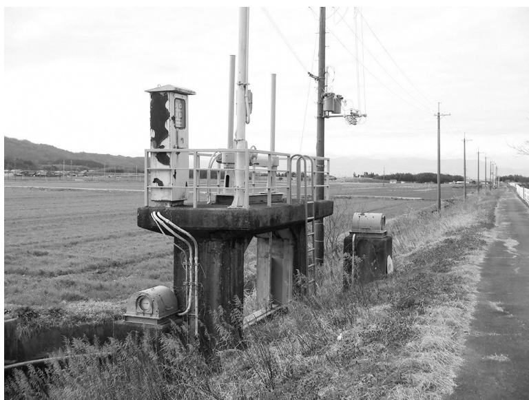
小口地先の樋門
