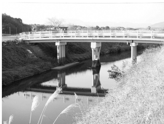
薬師橋（パイルベント橋脚）
