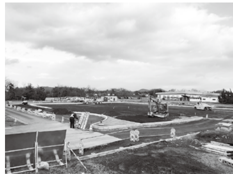
竜王かがみの里駐車場整備状況
