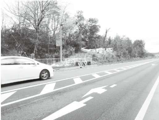
国道477号の歩道未整備区間
