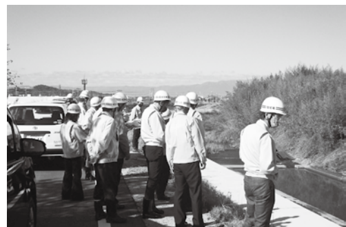
祖父川河川改良工事視察
