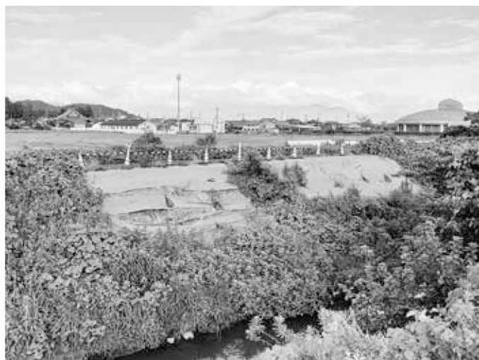
仮復旧中の惣四郎川右岸法面
