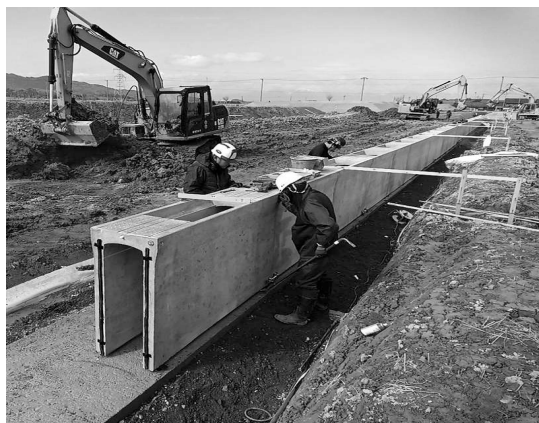
進む新設道路の側溝工事
