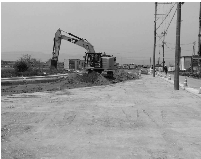
進んでいる中心核整備の道路工事
