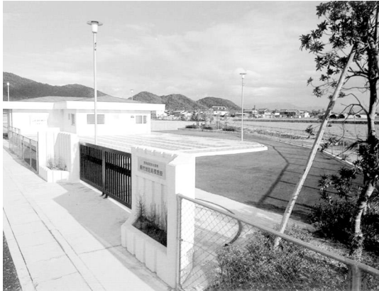
農業集落排水事業の 殿村（川守・岩井）地区処理施設
