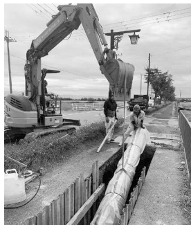
綾戸地先での工事
