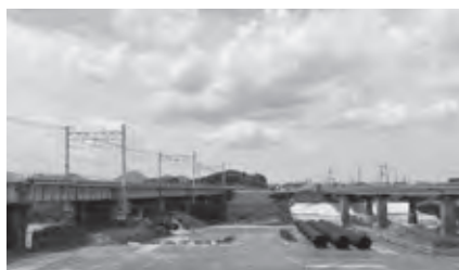
② J R 橋梁（桐原橋）
