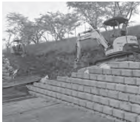
堤防強化工事（弓削地先）
