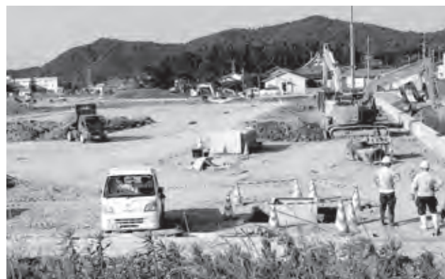
造成工事が進む中心核「交流・文教ゾーン」
