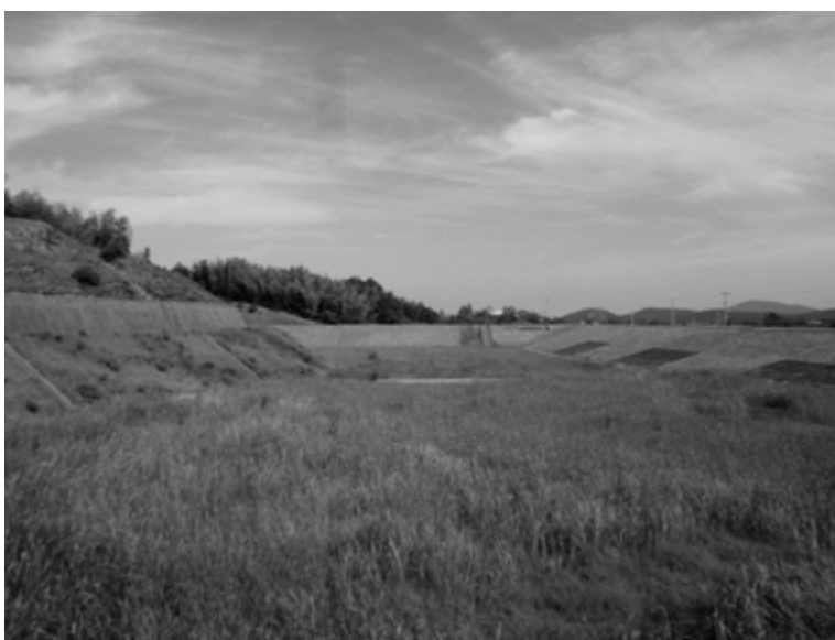
完成直後、整備されていた滋賀竜王工業団地の調整池の現況
