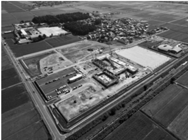
着々と工事が進む交流・文教ゾーン
